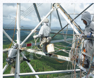
中空鋼管内面塗装作業
